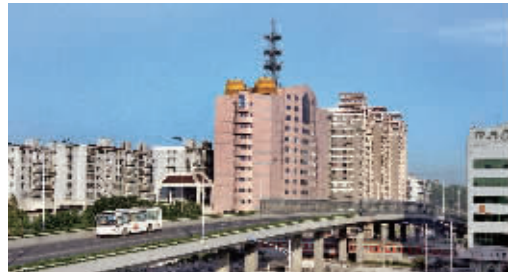
立交桥取代了老道口
