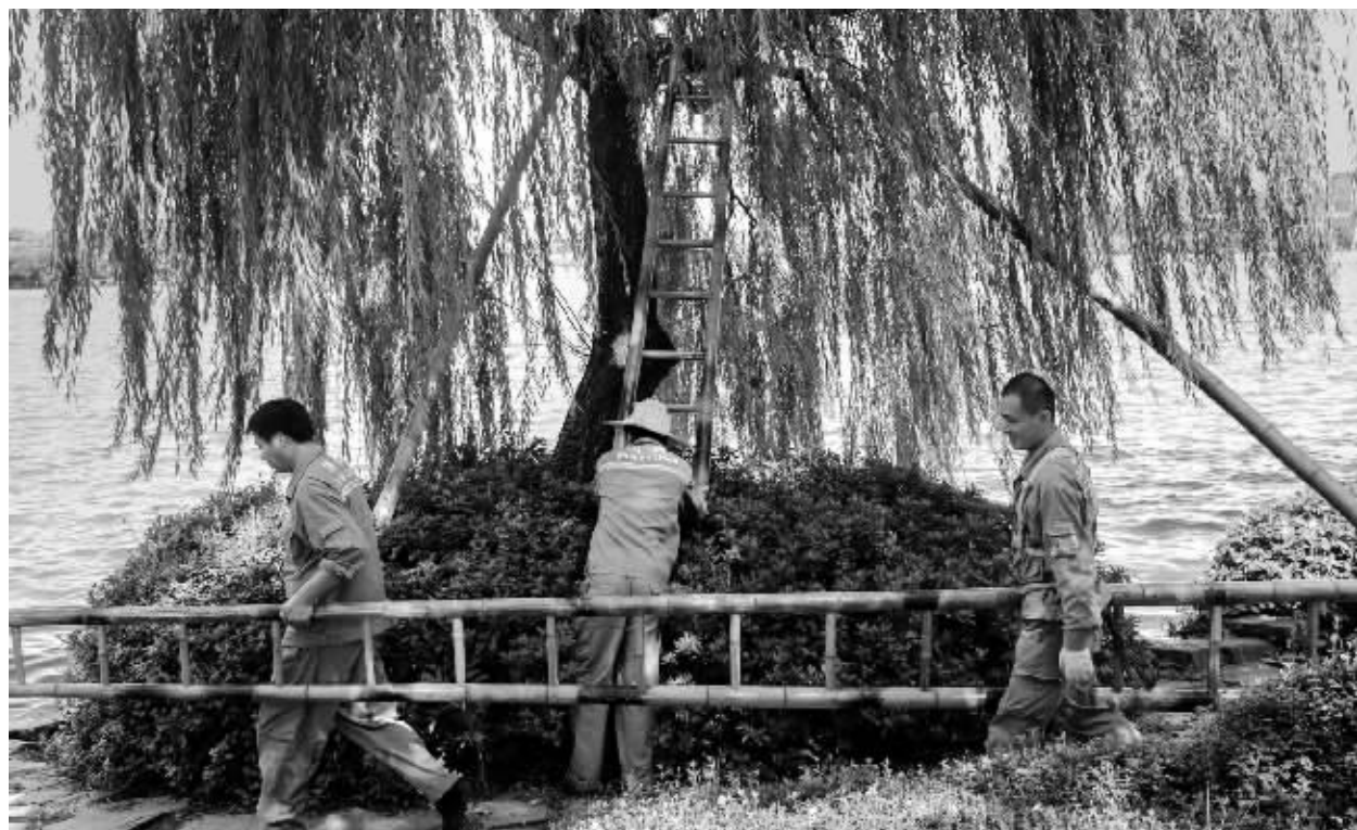
苏堤边,园林工人正在对树做加固防范措施,防止台风的侵袭。实习记者 周一豪 摄
