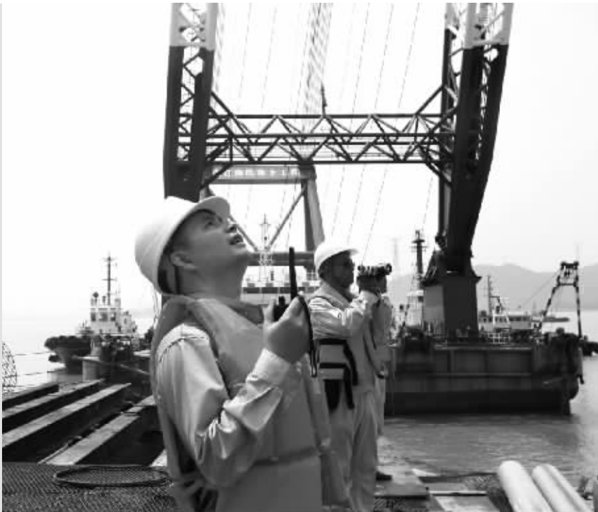
林东在施工现场。
